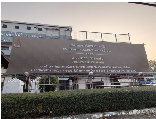
จุดติดตั้งป้ายไวเนล ขนาด ๓ x ๑๒ เมตร
