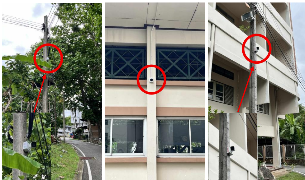
รูปที่ 7.2 กล้องวงจรปิด 24 ชั่วโมง หน้าอาคาร มร.2 / บริเวณทางเข้าอาคาร มร.3 และบริเวณข้างอาคาร มร.3
