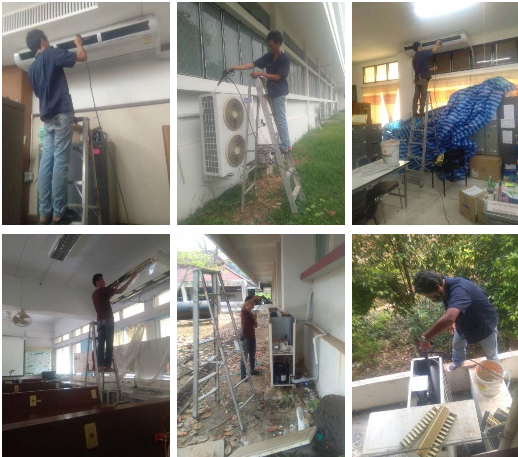
ภาพที่ 3.38 ตัวอย่างการบำรุงรักษาเครื่องปรับอากาศแบบแยกส่วน
