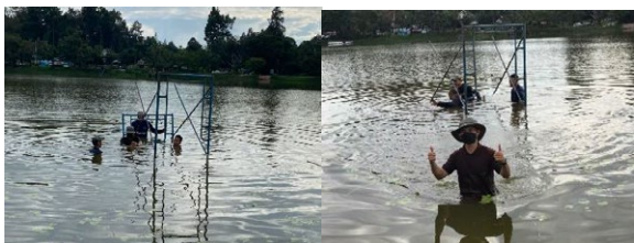
ภาพที่ 17 ติดตั้งนั่งร้านในหนองน้ำตามจุดที่กำหนด
