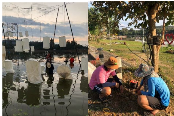
ภาพที่ 20 ปรับระดับและเดินสายไฟมายังตู้ควบคุม
