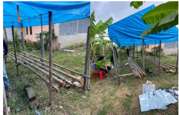
ภาพที่ 7 การสร้างโรงเรือนเพาะเห็ดฟางบ้านช้าง
