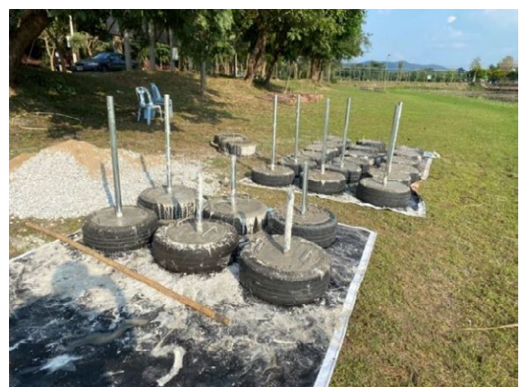
ภาพที่ 14 พื้นได้นำปูนซีเมนต์หล่อในยางรถยนต์เก่า
