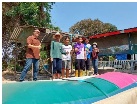
ภาพกิจกรรมที่ 8.4 บ่อแก๊สที่เสร็จสมบูรณ์
