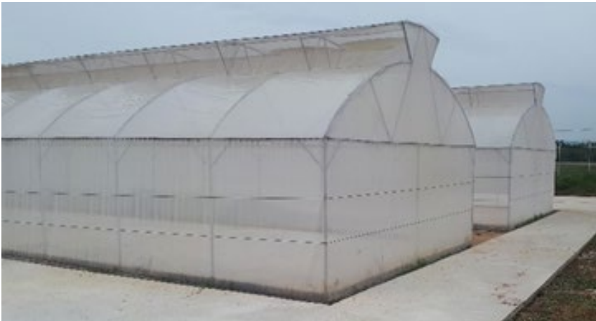
รูปที่ 15 โรงเรือนหลังคา 2 ชั้น
