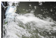
ภาพที่ 2.13 บั๊มน้ำที่ใช้หมุนเวียนน้ำในระบบ
