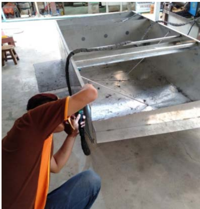
รูปที่ 9 การขึ้นโครงเครื่อง
