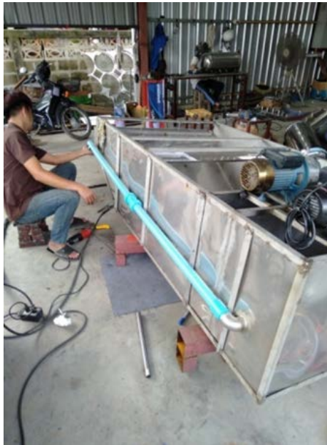
รูปที่ 14 การติดตั้งท่อ น้ำไหล
