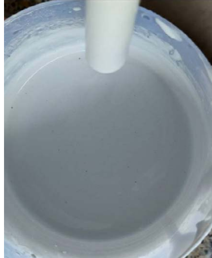
รูปที่ 8 คนปูนพลาสติกอร์ ระว่างการเกิดฟองอากาศ
