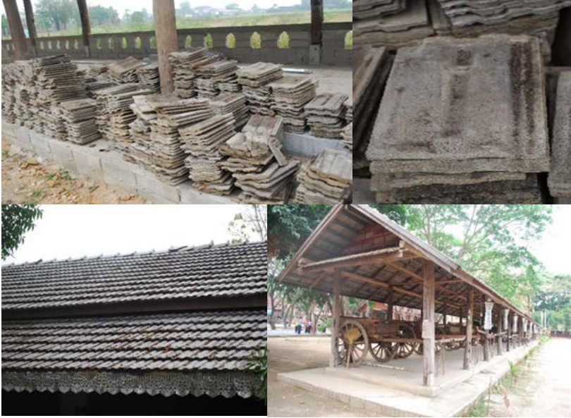
ภาพที่ 11 รูปแบบของกระเบื้องหลังคาโบราณด้วยซีเมนต์ วัดร่องหลอด
