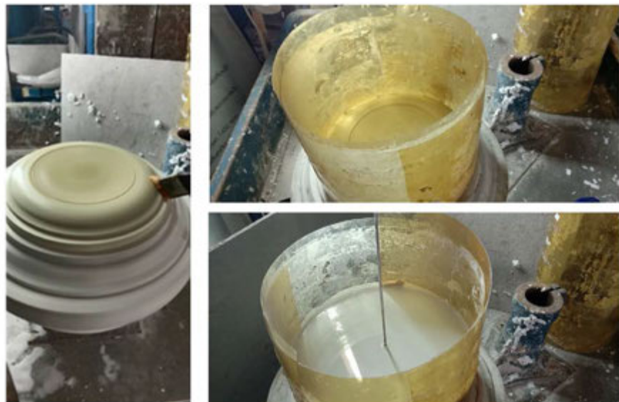
ภาพแสดงการทำน้ำสบู่แล้วกันคอกหล่อปูนพลาสติกอร์
