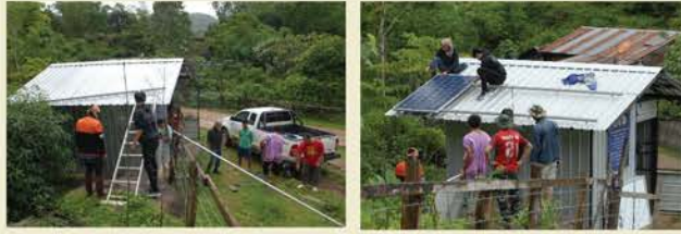
รูปที่ 8 การติดตั้งแผงโซลาร์เซลล์
