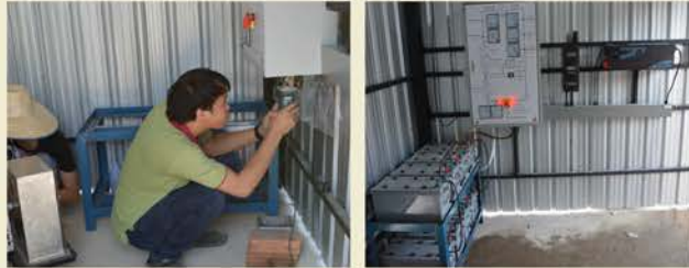
รูปที่ 9 การติดตั้งอุปกรณ์ควบคุมระบบผลิตไฟฟ้าพลังงานผสมผสาน
