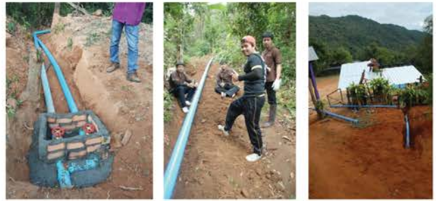
รูปที่ 4 การติดตั้งระบบท่อส่งน้ำ
