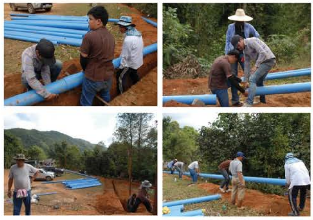
รูปที่ 7 การติดตั้งระบบท่อระบายน้ำ
