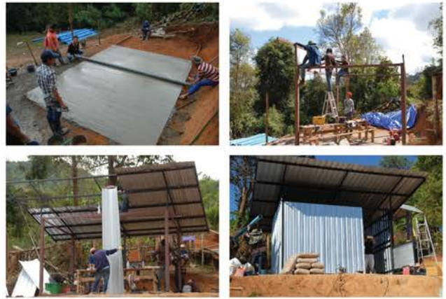
รูปที่ 5 การสร้างอาคารโรงไฟฟ้า
