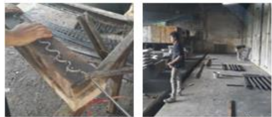
รูปที่ 2 การเตรียมชิ้นส่วนเพื่อต่อเก๊ตเป็น 6 ชั้น
