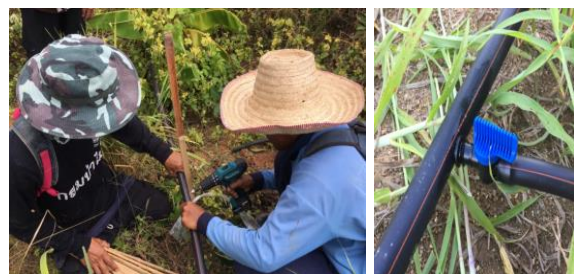
ภาพที่ 10 การติดตั้งวาล์วท่อแขนงและท่อแขนง
