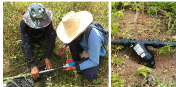
ภาพที่ 9 การติดตั้งวาล์วท่อประธานและตัวกรอง
