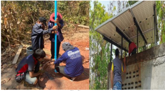
ภาพที่ 8 การติดตั้งปั๊มพลังงานแสงอาทิตย์
