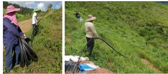
ภาพที่ 8 การติดตั้งท่อประธาน
