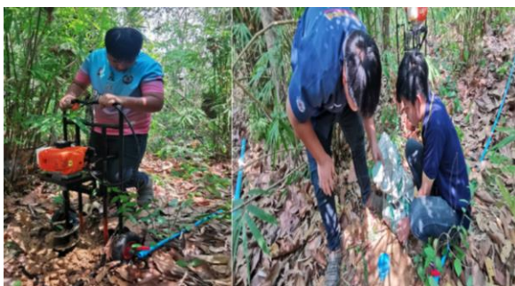
ภาพที่ 9 การติดตั้งระบบธนาคารน้ำใต้ดิน
