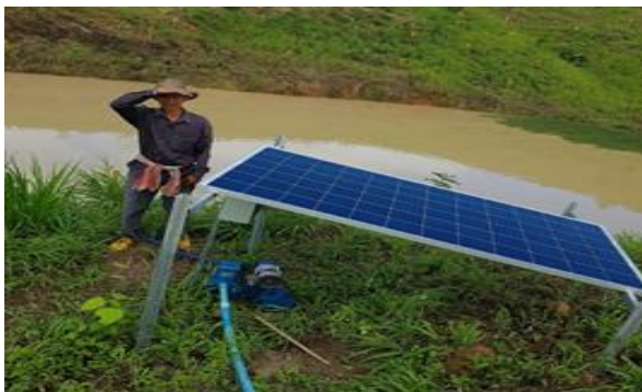
ภาพที่ 6 การติดตั้งระบบสูบน้ำพลังงานแสงอาทิตย์
