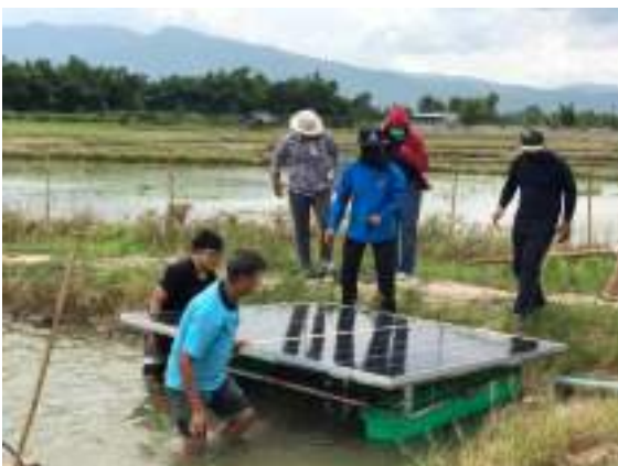
รูปที่ 5 ติดตั้งแผงโซลาร์เซลล์เพื่อพลังงานที่ยั่งยืน ณ ศูนย์เรียนรู้ฯ
