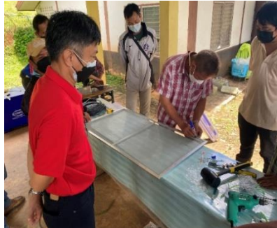
การประกอบและติดตั้งมุ้งลวด
