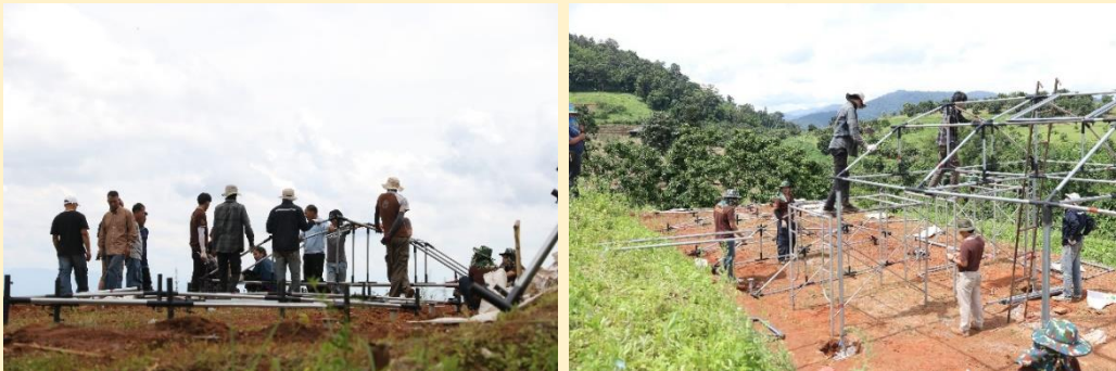
การขึ้นโครง และติดตั้งโรงเรือนน็อคดาวน
