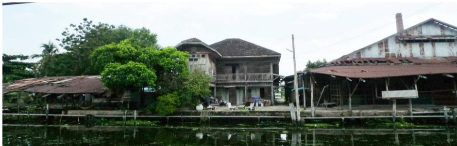
สภาพอาคารก่อนปรับปรุงเป็นร้านอาหาร
