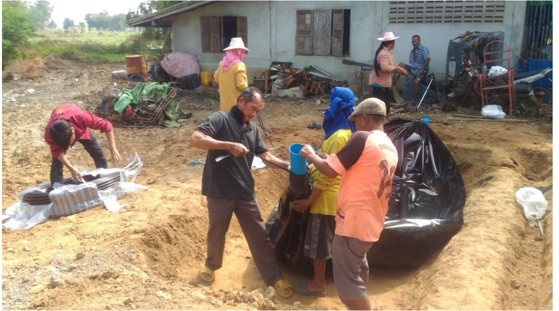
ภาพผนวกที่๙ การติดตั้งบ่อแก๊สชีวภาพ
