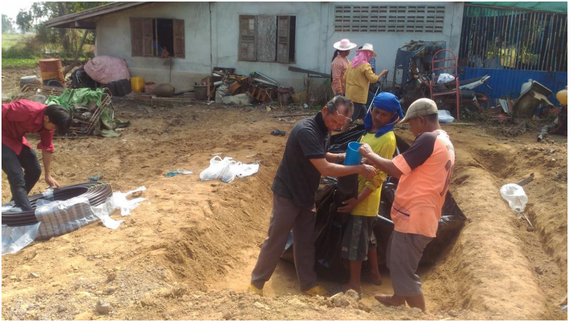
ภาพกิจกรรมที่ ๕.๑ การเตรียมบ่อแก๊สและอุปกรณ์
