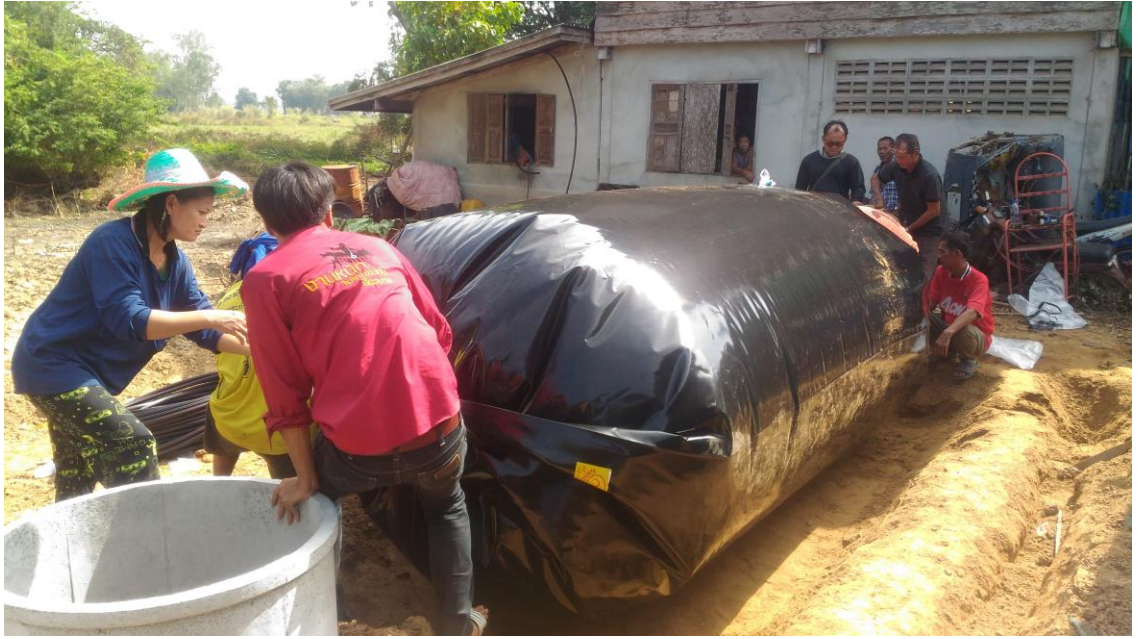
ภาพกิจกรรมที่ ๕.๓ การติดตั้งบ่อแก๊สและระบบความปลอดภัย
