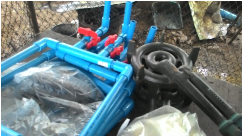
ภาพกิจกรรมที่ 3.4 การวางท่อและระบบความปลอดภัย
