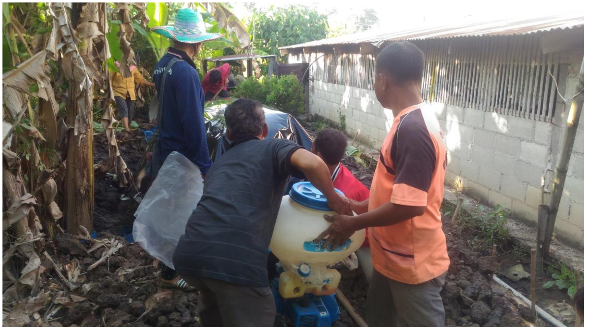
ภาพกิจกรรมที่ 6.2 การติดตั้งบ่อแก๊สชีวภาพ
