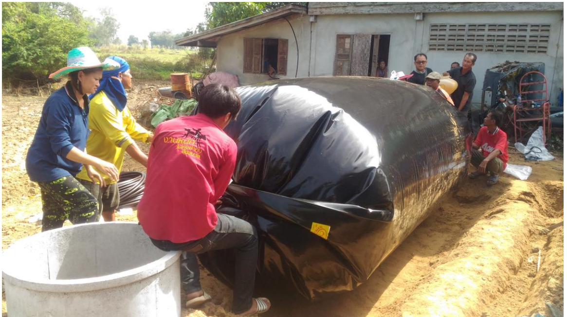
ภาพกิจกรรมที่6.4 การติดตั้งสายแก๊สและระบบความปลอดภัย
