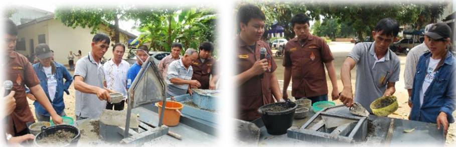
ภาพที่ 7 แต่งผิวหน้าให้เรียบและขัดมันผิวหน้าแผ่นกระเบื้องด้วยปูนซีเมนต์ผง
