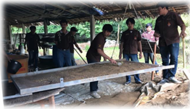
ภาพที่ 3 ร่อนทรายด้วยตะแกรงร่อน
