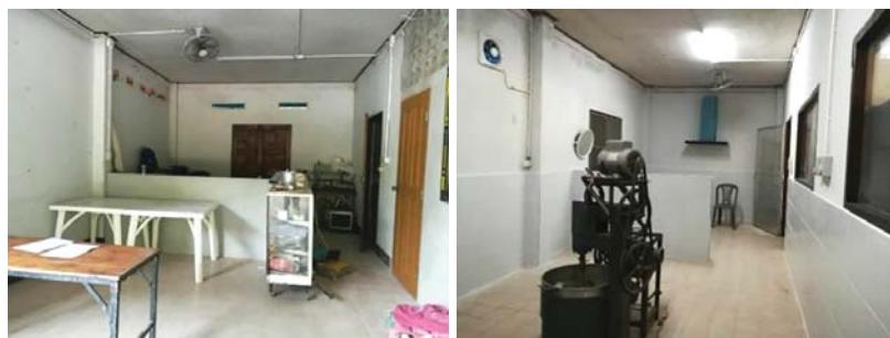
ภาพที่ 3 บริเวณอาคารผลิตที่ต้องทำการปรับปรุงให้ถูกต้องตามมาตรฐาน
