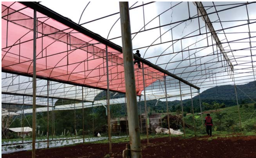
รูปที่ 7 ประกอบโครงสร้างโรงเรือน
