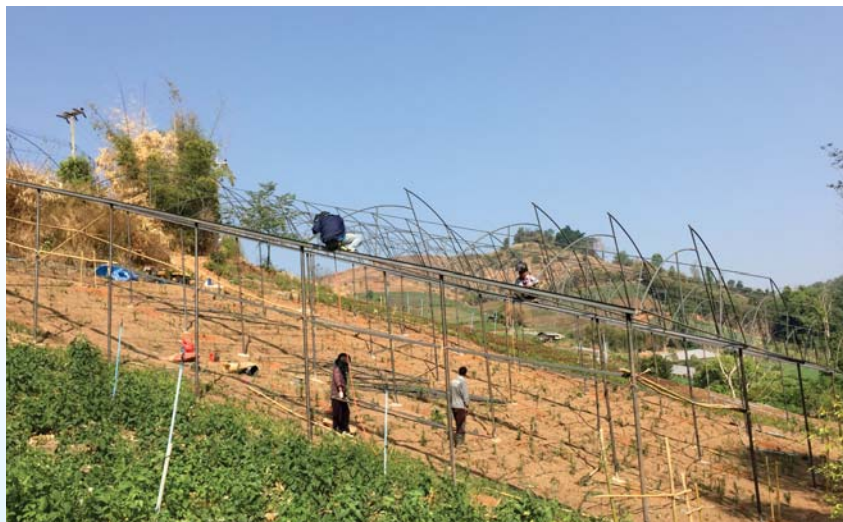
รูปที่ 6 ประกอบโครงสร้างโรงเรือน
