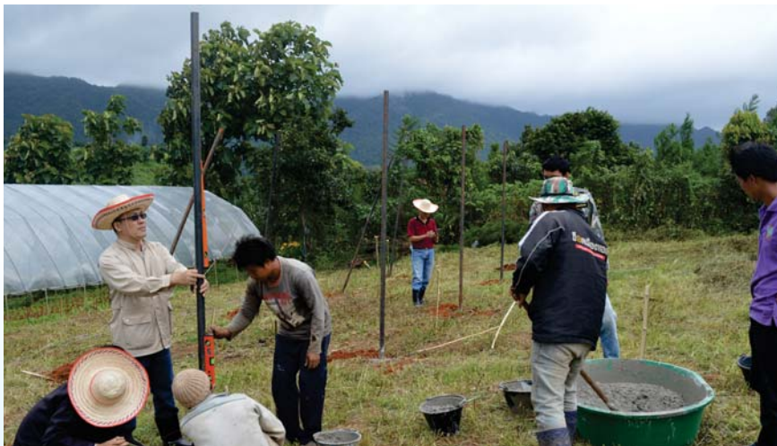
รูปที่ 5 การกำหนดขอบเขตและการวางผังโรงเรือน
