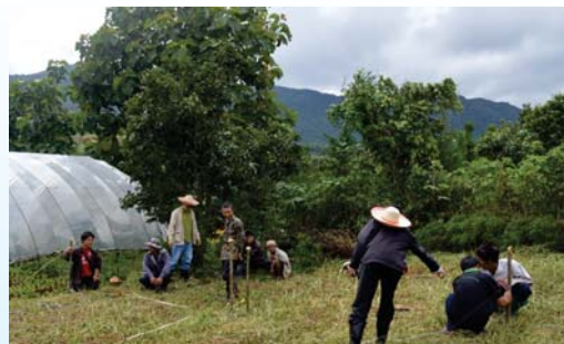
รูปที่ 4 การกำหนดขอบเขตและการวางผังโรงเรือน
