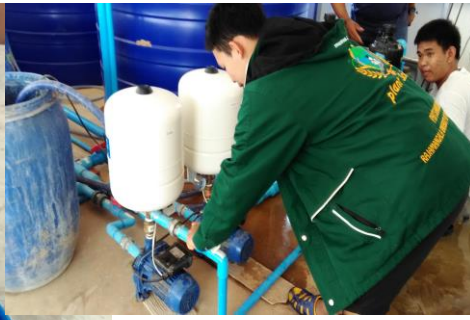
ควบคุมระบบการทำงานของปั้มน้ำ
