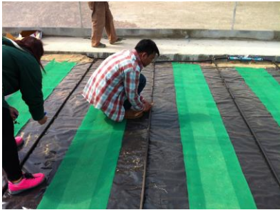
วางท่อน้ำหลัก
